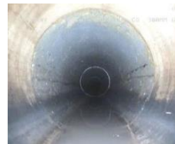
Drain CCTV 地渠勘察
