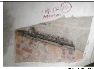
Anti-rust Treatment 防銹處理
