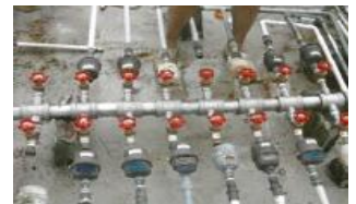
Replace Water Supply 食水系統更換
