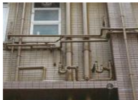
Replace Drain 渠務更換
