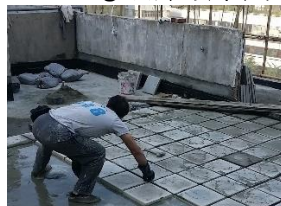
Waterproofing 天台防水
